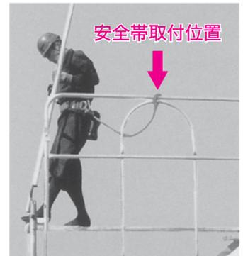
▲足場の先端部に建柱を取り付ける場合にはスカイガードの手すりに安全帯を取り付ける。
