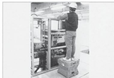
**絶縁体**なので電気・通信工事に最適
