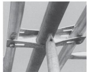
▲上部金具を上へ引き上げ、建柱に水平に突きあてた状態。
